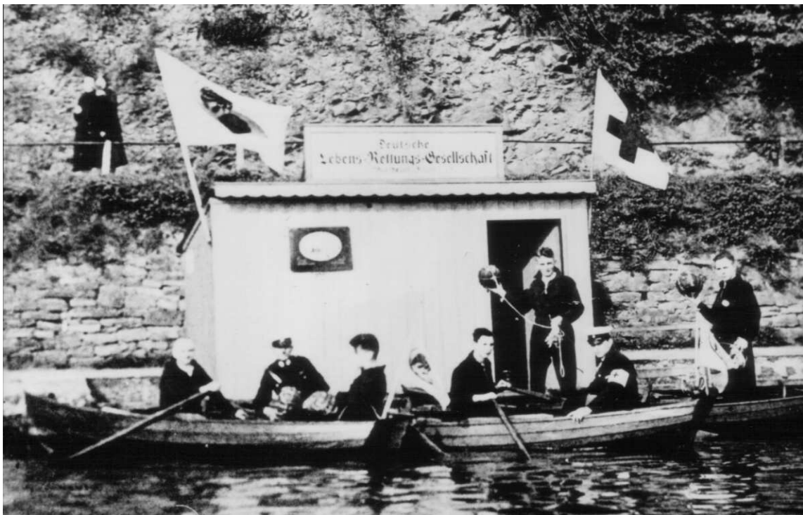
Die DLRG Station unterhalb der heutigen Jugendherberge an der Mendener Straße
